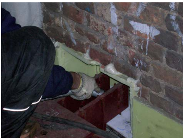
Рис. 3. Узел анкерки монолитного пояса в гнездо кладки отнесенной стены, продувка наклонного шпура для монтажа химического анкера
