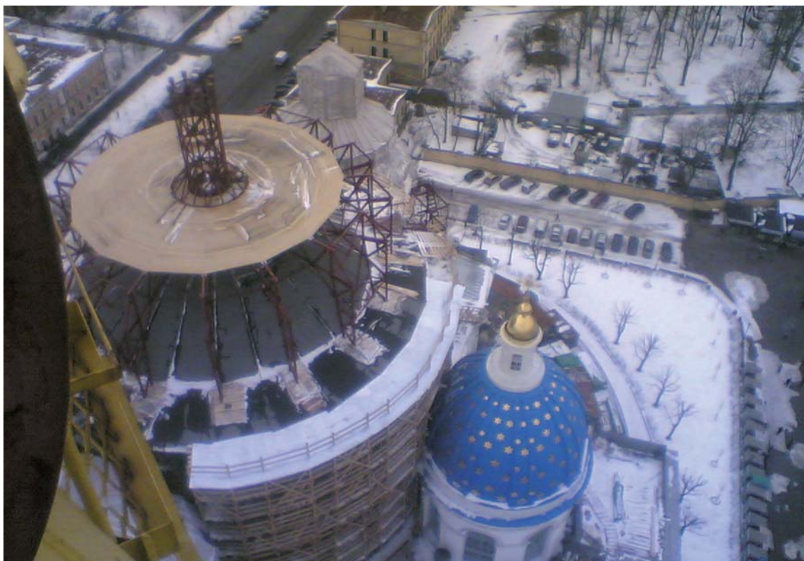
Рис. 6. Монтажный кондуктор (вид со стрелы башенного крана)
