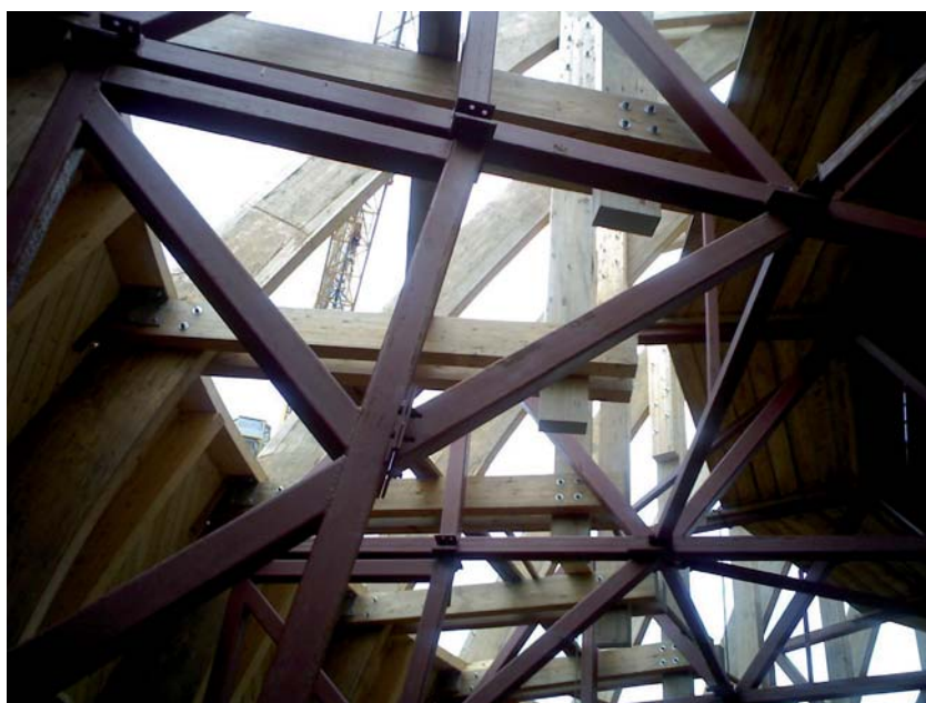
Рис. 7. Монтажный кондуктор (узел опирания ребра)
